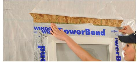
7. Quand c'est fait, repliez le revêtement de maison en place sur la partie de linteau de WindowWrap®, puis vous pouvez fixer par de la bande autocollante, du WindowWrap®, ou en agrafant. Les propriétés auto-scellantées de WindowWrap lui permettent d'étanchéifier autour des clous, des vis ou des agrafes utilisés pour recouvrir la maison.
