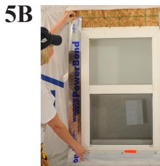
6. Collez du WindowWrap® sur le rebord de linteau et le mur de contreventement. Cette section doit dépasser les sections de montants des deux côtés. Ces dernières ne doivent pas monter plus haut que la section de linteau.
