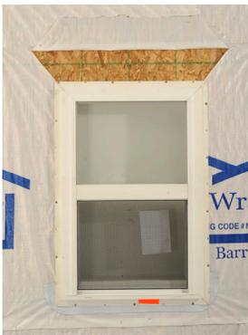
5. Collez des sections verticales de WindowWrap® (5A et 5B) sur les rebords de montants (côtés) et sur le mur de contreventement ou le revêtement de maison. La bande verticale doit chevaucher la bande en bas, et dépasser de 7,5 cm au-dessus de l'ouverture brute en haut, de préférence sur l'habillage exposé.
